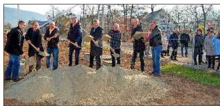
Den Spatenstich tätigten (von links) der ehemalige Grundstückseigentümer Karl Blattmann, INWO-Projektleiter Hans Peter Buchholz, REWE-Bauleiter André Epp, INWO-Inhaber Jürgen Machmann, Bürgermeister Karl Josef Herbstritt, Hauptamtsleiter Konrad Hiltzinger, REWE-Markt-Initiator Dieter Schneider und INWO-Bauleiter Markus Bandle. Foto: Alex Zane
